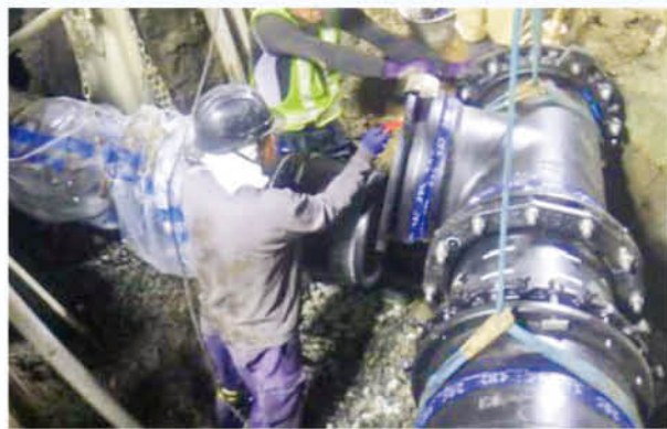
▲老朽化した水道管更新工事の様子
