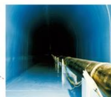
⑤ 湯村山トンネル配水池
