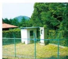
⑨ 東部第1配水池
