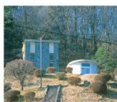
⑥ 高区(和田)配水池
