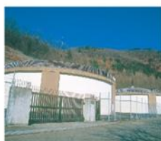
③ 羽黒配水池
