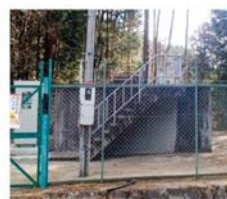
④ 千代田配水池
