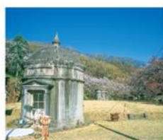
⑦ 中区(愛宕)配水池
