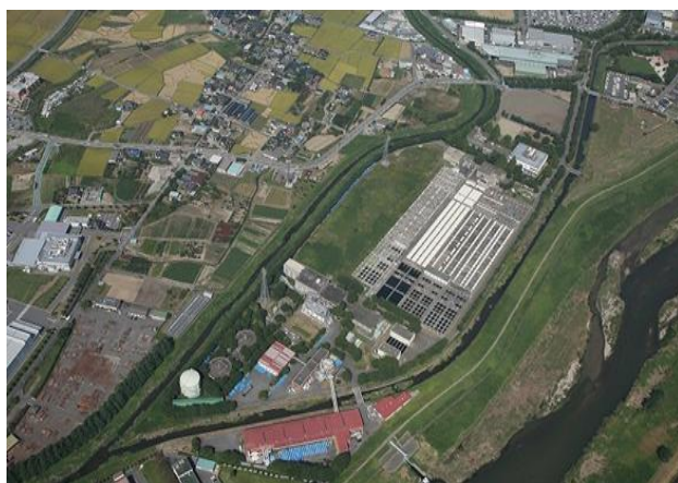
甲府市浄化センター
