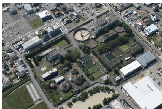
住吉中継ポンプ場
