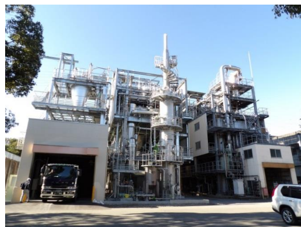
甲府市浄化センター汚泥焼却施設
