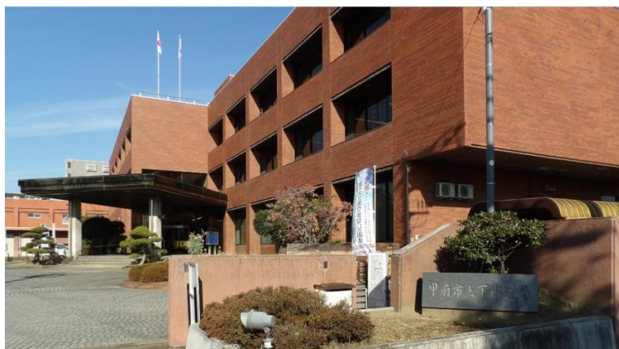
甲府市上下水道局本庁舎
