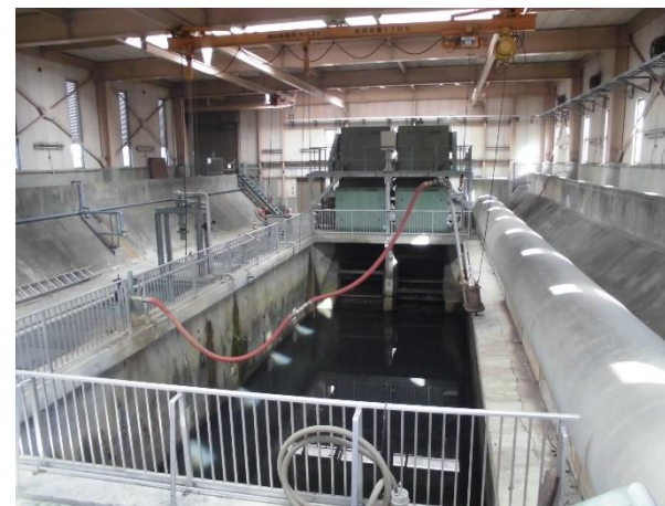
【ポンプ場施設】
