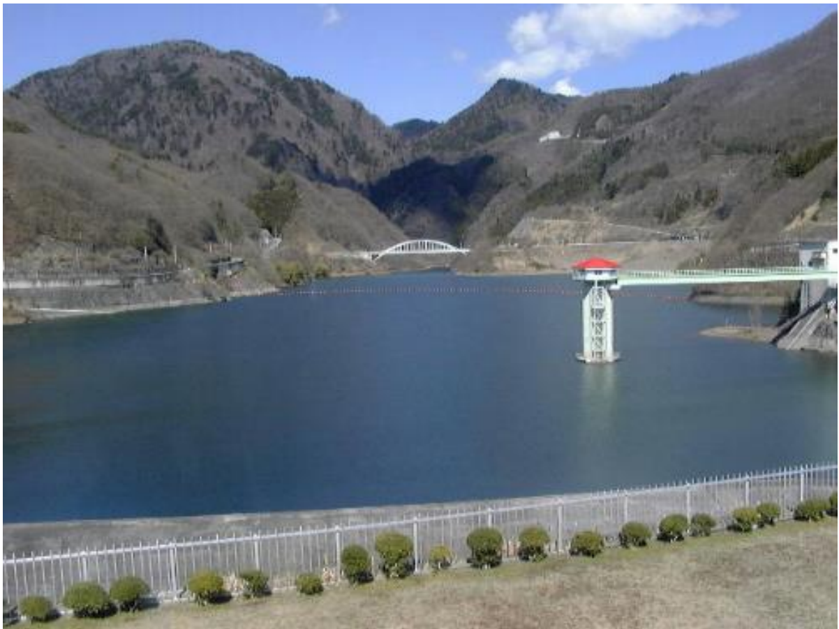
写真 荒川ダムと取水塔
