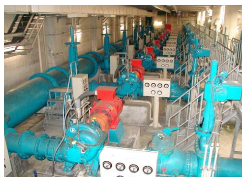
昭和浄水場 ポンプ室
