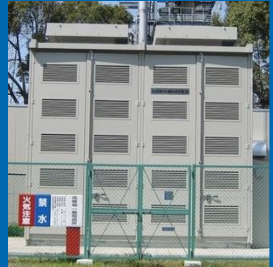
NaS電池システム
