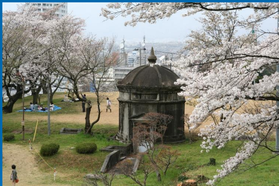
中区配水池 (現在:平成27年4月)
