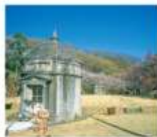
⑰ 中区(愛宕) 配水池
