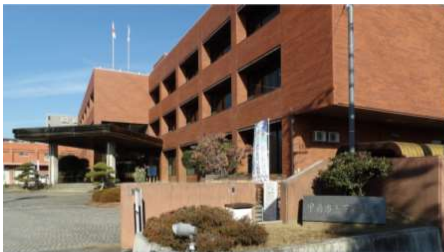
甲府市上下水道局本庁舎
