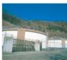
⑬ 羽黒配水池
