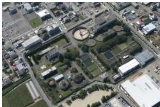
住吉中継ポンプ場
