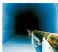
⑮ 湯村山トンネル配水池
