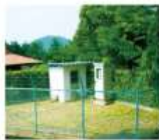
⑲ 東部第1配水池
