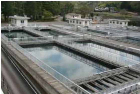
平瀬浄水場沈砂池
