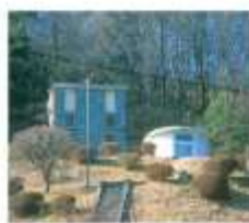
⑯ 高区(和田) 配水池
