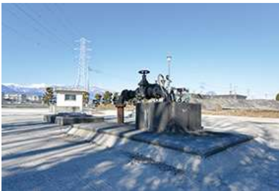
昭和浄水場取水井
