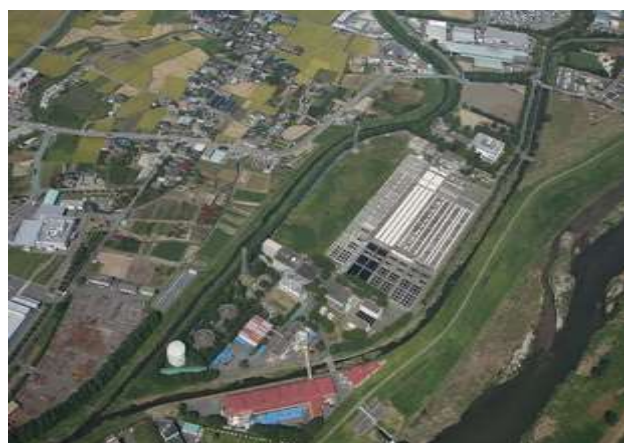
甲府市浄化センター
