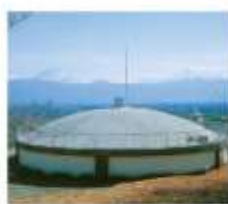
⑪ 高区西(旧敷島) 配水池
