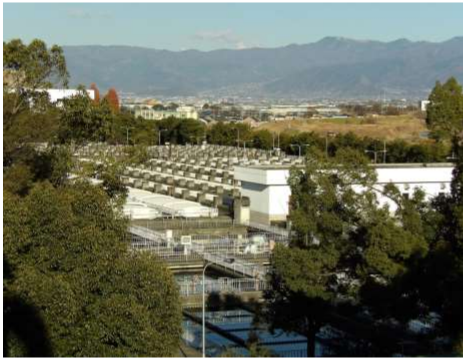
甲府市浄化センター沈澱池
