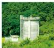
⑲ 南部第1配水池
