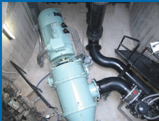
山宮発電所 (小水力発電)
