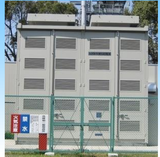
ナトリウム硫黄電池 システム
