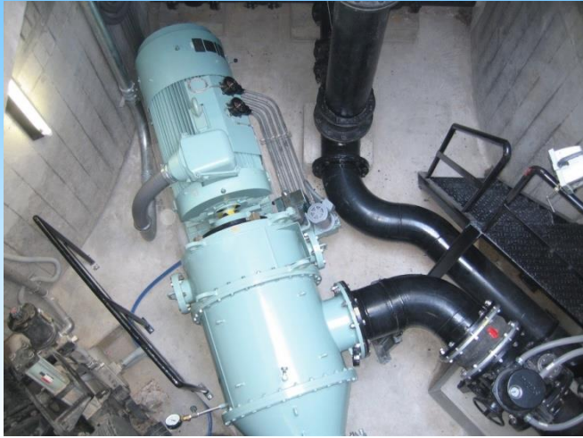
山宮発電所 (小水力発電)
