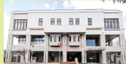
甲府市浄化センター 耐震工事
