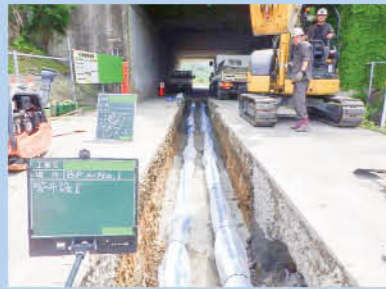
水道管取替工事
