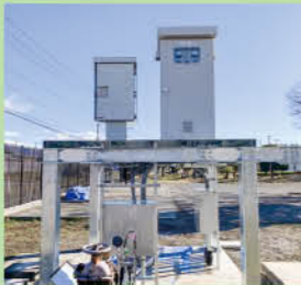
昭和浄水場制御盤 かさ上げ工事
