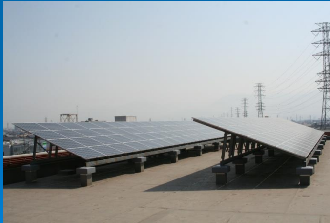
上下水道局庁舎 太陽光発電システム
