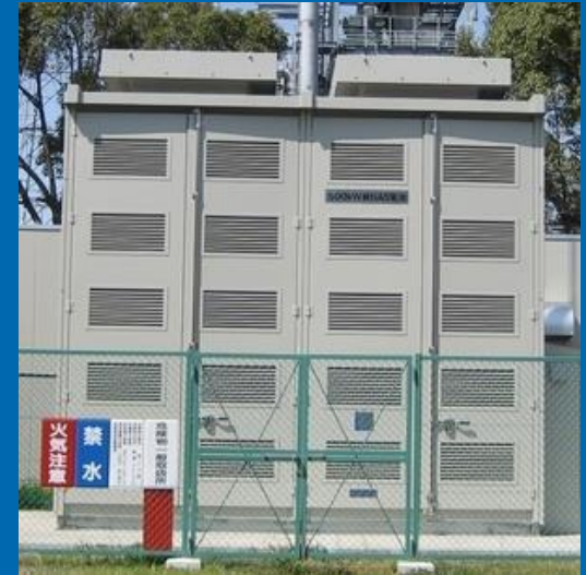
NaS電池システム (ナトリウム・イオウ蓄電池)
