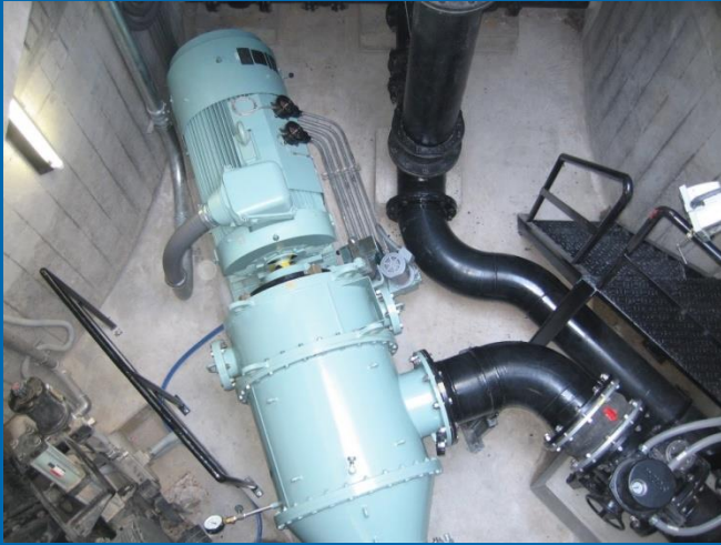
山宮減圧槽内発電装置 (小水力発電)
