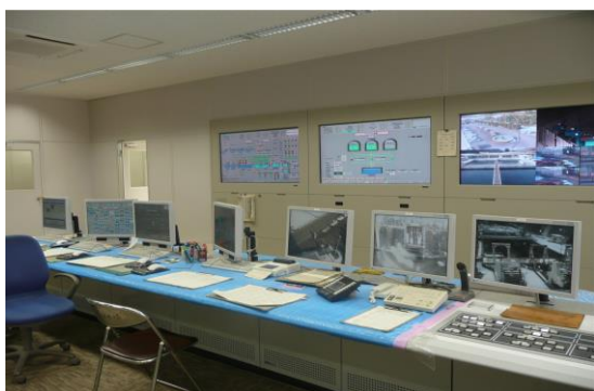
平瀬浄水場 操作室
