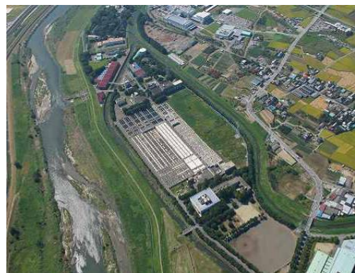
甲府市浄化センター
