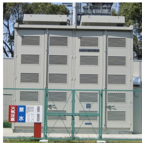
浄化センターNaS電池システム
