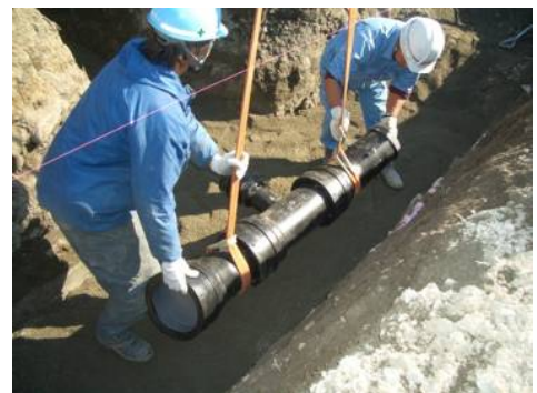
耐震管布設工事
