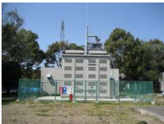
【NAS電池設備（甲府市浄化センター）】
