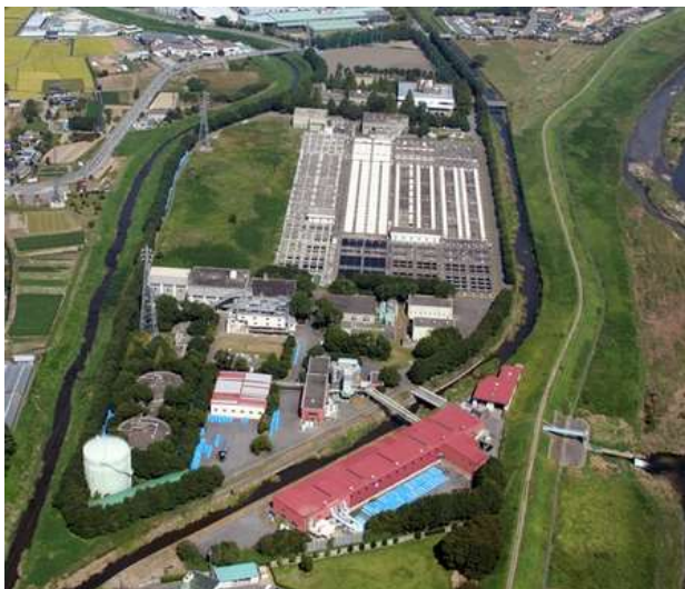
【甲府市浄化センター（大津町）】
