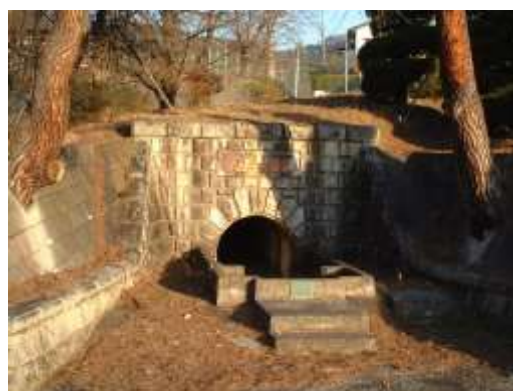
平瀬浄水場旧取水口門部
