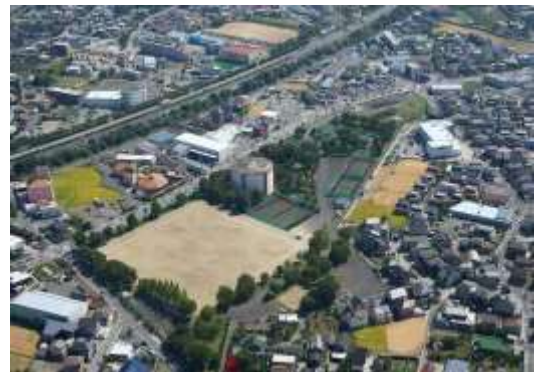
【昭和北方水源】 中巨摩郡昭和町西条 2387
