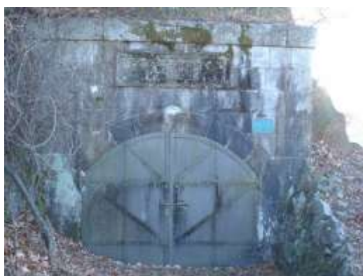
平瀬浄水場旧片山隧道上口
