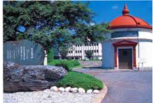
【平瀬浄水場】 甲府市平瀬町 437-3
