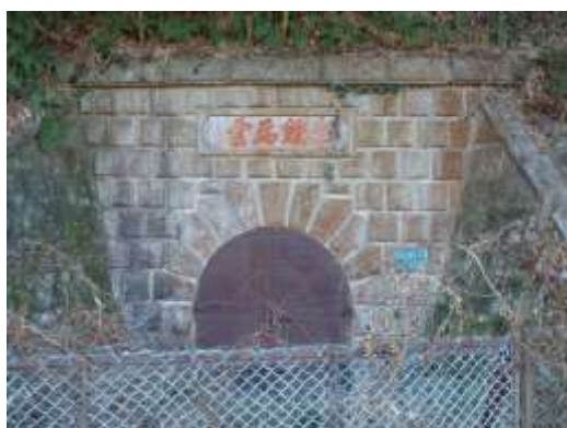
平瀬浄水場第 2 隧道上口
