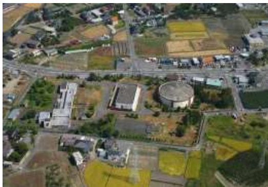
【昭和浄水場】 中巨摩郡昭和町西条 1413
