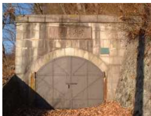
平瀬浄水場旧片山隧道下口
