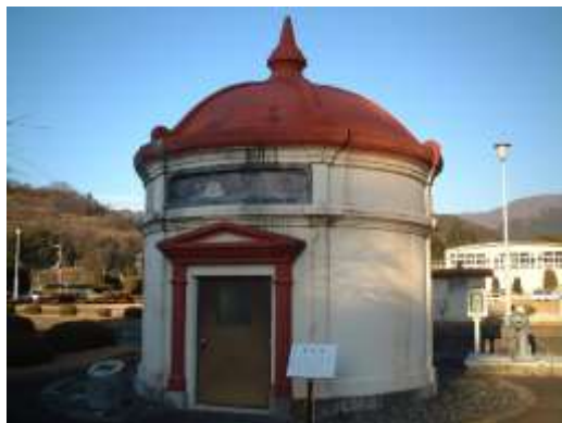
平瀬浄水場旧ろ過池整水井
