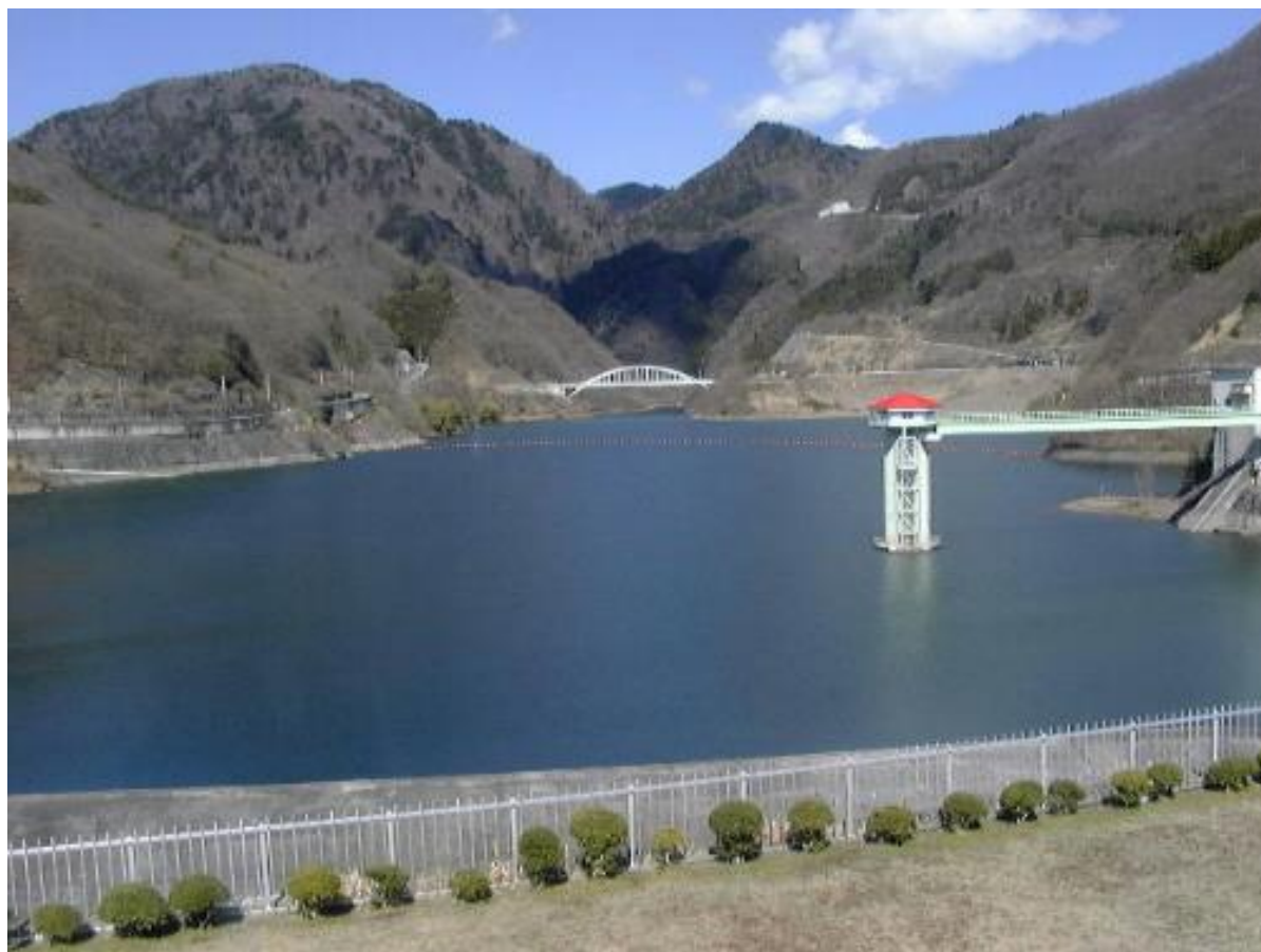
写真 荒川ダムと取水塔
