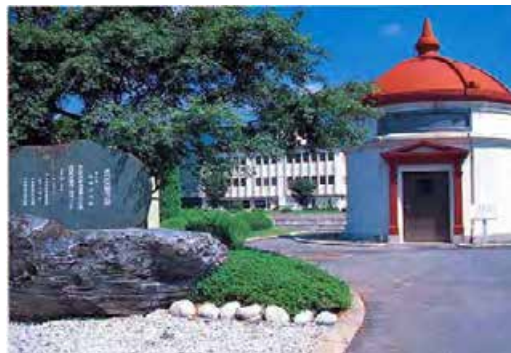
【平瀬浄水場】 甲府市平瀬町 437 番地 3
