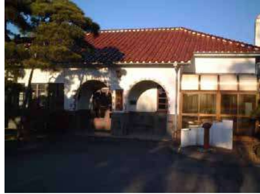
平瀬浄水場旧事務所 築造年：昭和10年 登録原簿登録日：平成9年12月12日
