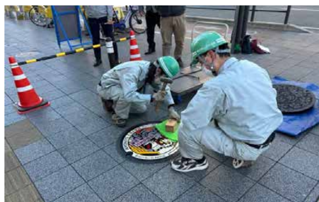
ガンダムマンホールの設置 （2月26日）
