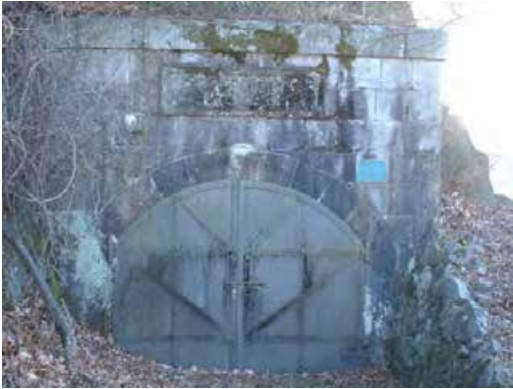
平瀬浄水場旧片山隧道上口 築造年：大正2年 登録原簿登録日：平成10年10月9日
