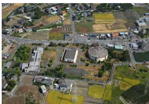
【昭和浄水場】 中巨摩郡昭和町西条 1413 番地
