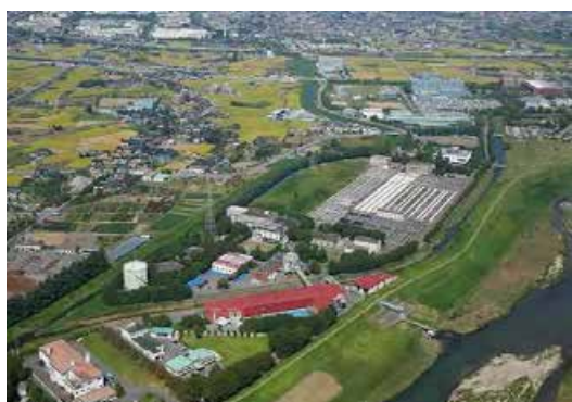
【甲府市浄化センター】 甲府市大津町 1645 番地
