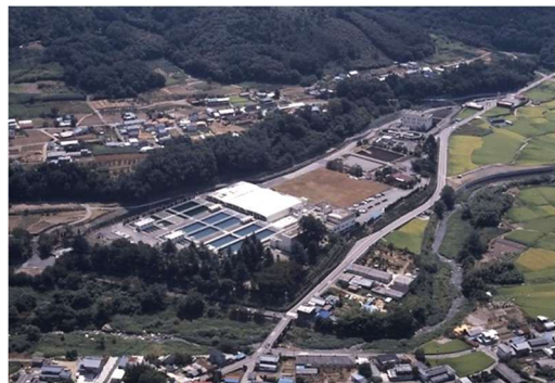
【平瀬浄水場】 甲府市平瀬町 437 番地 3
