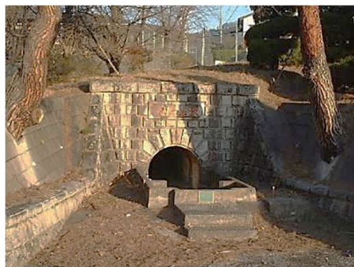
平瀬浄水場旧取水口門部
