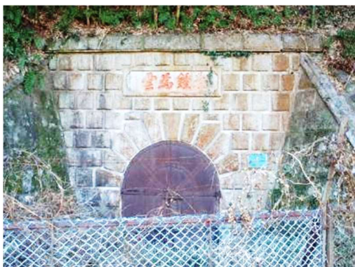
平瀬浄水場第 2 隧道上口
