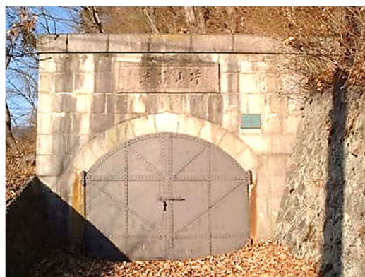
平瀬浄水場旧片山隧道下口
