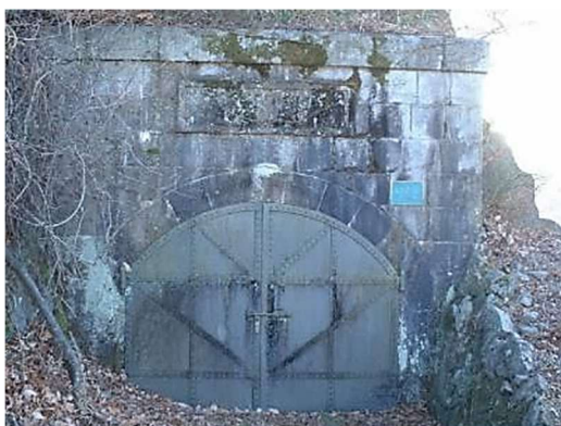
平瀬浄水場旧片山隧道上口
