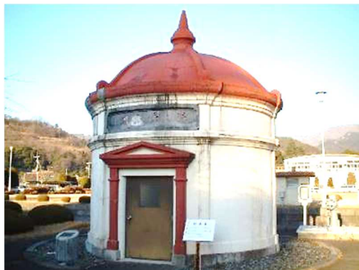
平瀬浄水場旧ろ過池整水井
